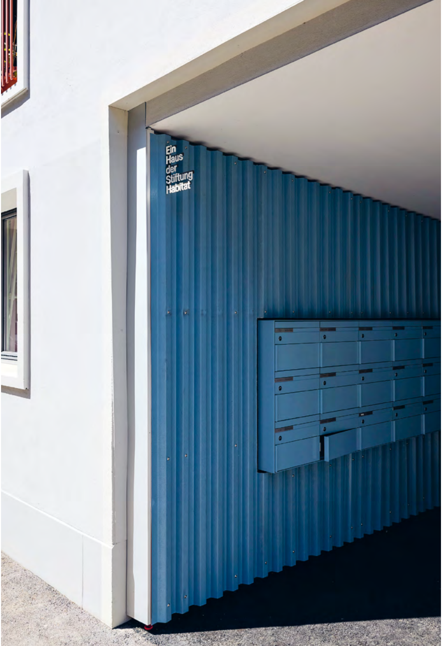
Hauseingang Sperrstrasse 91 nach Sanierung
