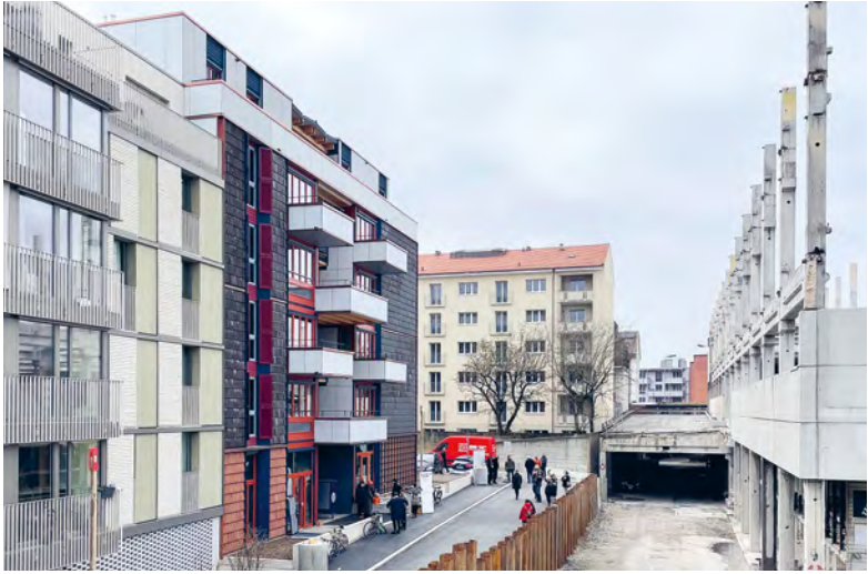
Neubau an der Weinlagerstrasse 33 kurz vor der Fertigstellung
